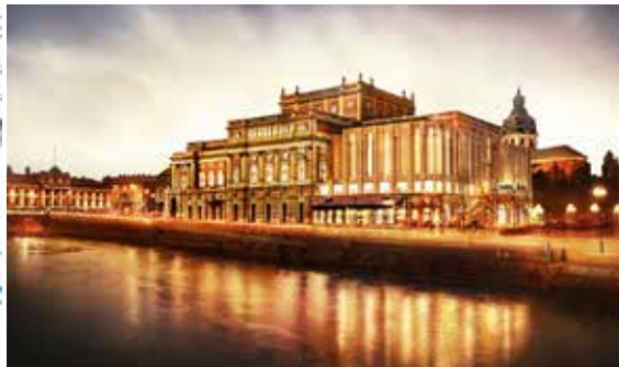
Ombyggnad Kungliga Operan
